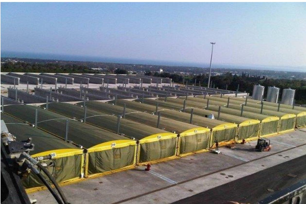
Рисунок 4.1-13 – Участок мембранного компостирования BioE/GORE
